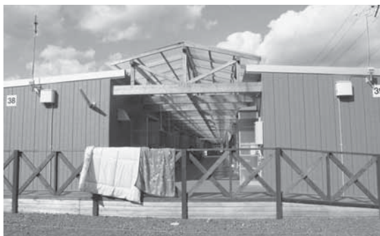
釜石市平田地区の仮設住宅 東京大学高齢社会総合研究機構の発案で玄関を向かい合わせにし、間にウッドデッキを渡して屋根をつけた。
